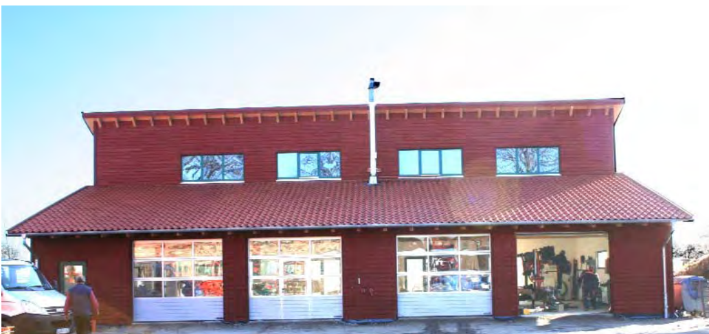
Das neue Werkstattgebäude ist seit Dezember 2007 in Betrieb.
