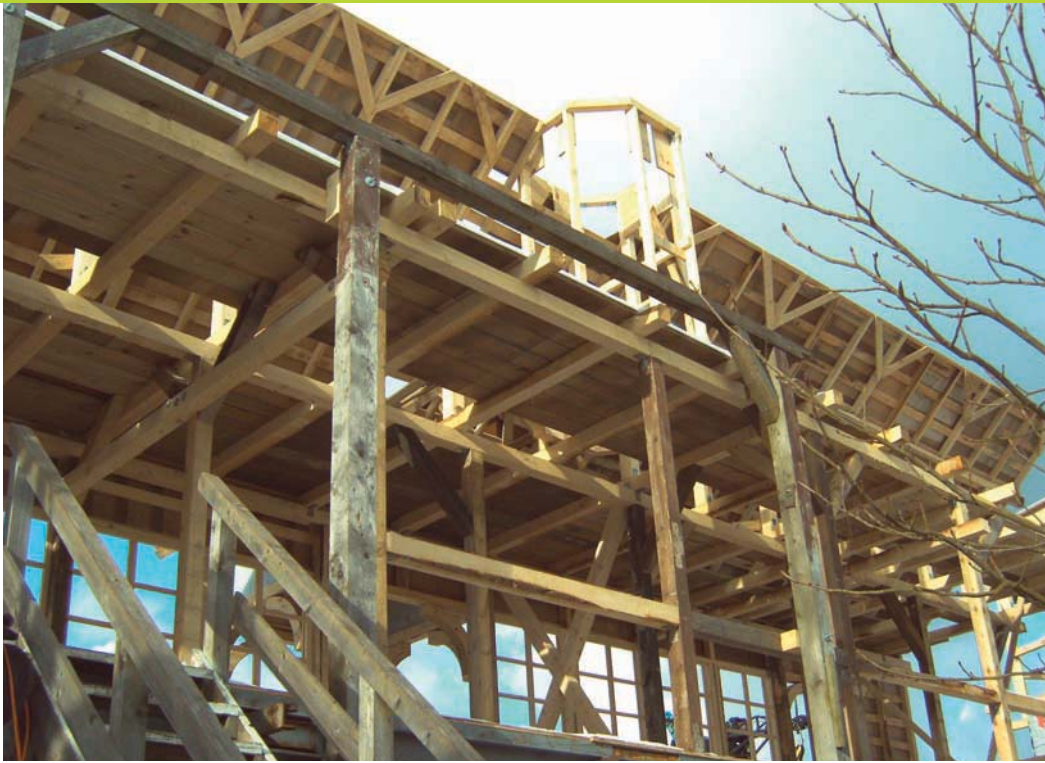
Rückseite des linken Bühnenbildes. ins gesamt werden mehr als 400 Fm Holz verbaut
