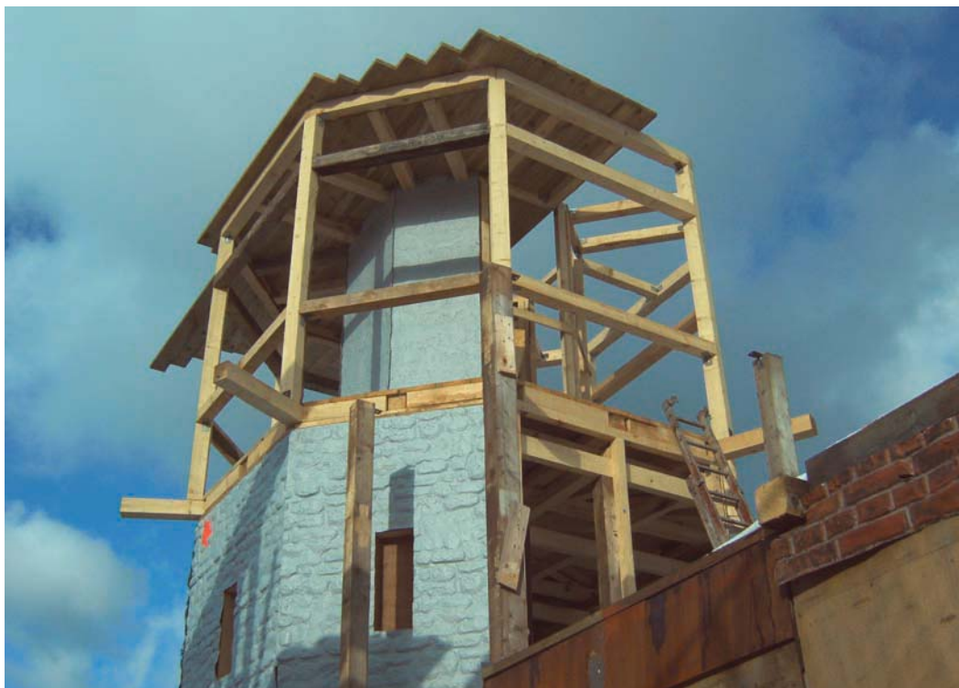
Die Fassade ist mit Hartfaserplatten und Kunststoff verkleidet. Die ganze Konstruktion muss Wind bis Stärke 10 aushalten können.
