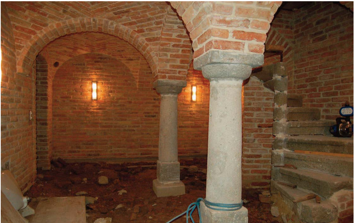
Beeindruckendes Kellergewölbe wird neu aufgebaut
