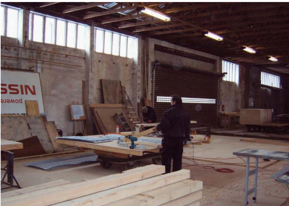
Alle Wände werden im alten Sägewerk, etwa 2km von der Bühne entfernt, vormontiert
