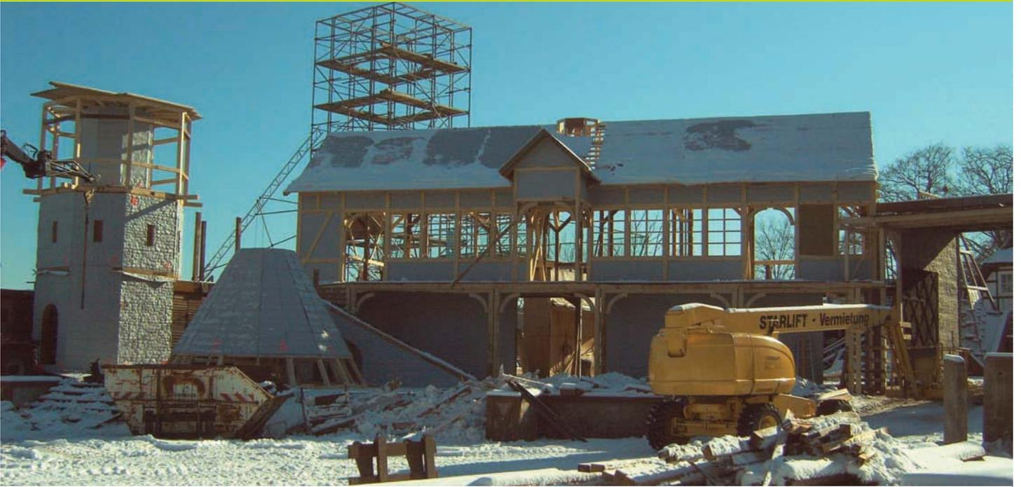
Die vormontierten Wände werden mit einem Kran aufgestellt.
