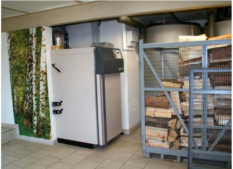
*Eine Gitterbox mit Holz steht direkt vor der Stückholz-Zentralheizung. Im Hintergrund sieht man die Pufferspeicher für 3000l Wasser*
