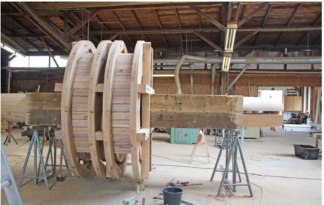
Die Seltrommel als Bestandteil der Wasserkunst im Besucherbergwerk in Rammelsberg bei Goslar – alle Teile, die ersetzt werden mussten, konnten mit der LT20 gesägt werden.
