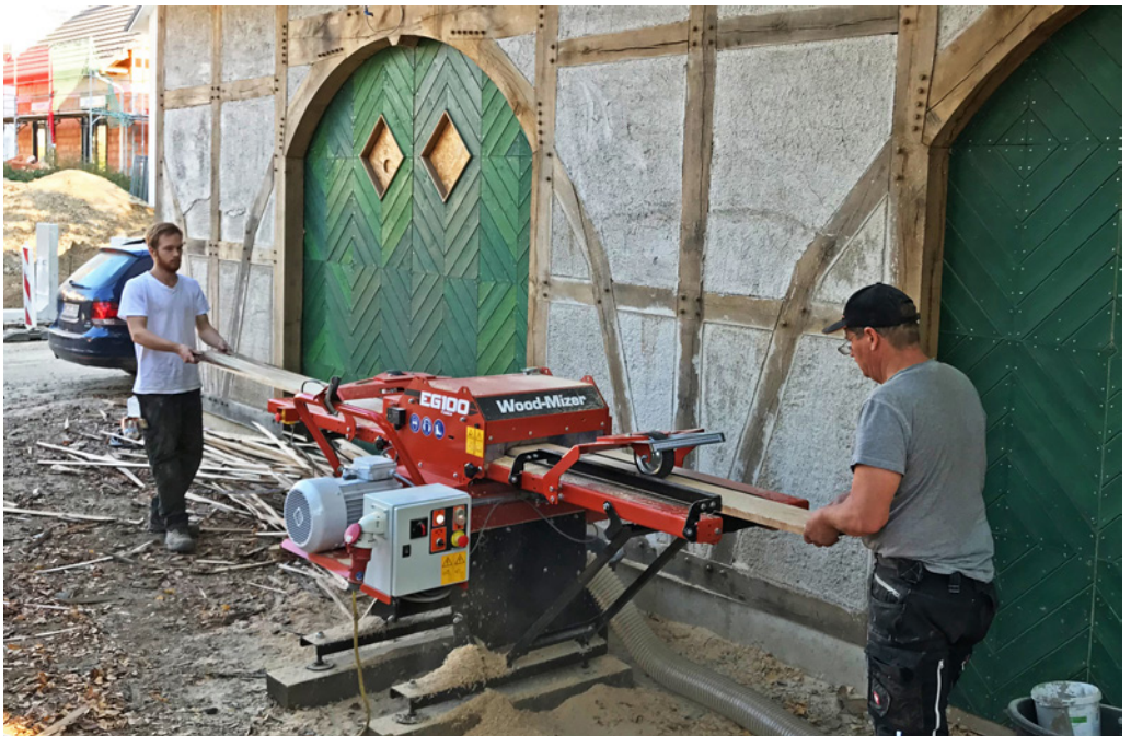
Die EG100 Besäumsäge gehört zum Equipment der Firma und wird direkt mit zur Baustelle genommen.
