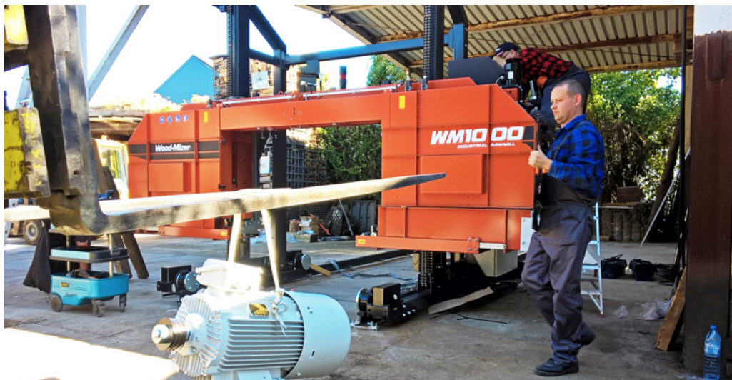
Der Motor wiegt 180 kg und wird mithilfe des Staplers an seine Position gehoben.
